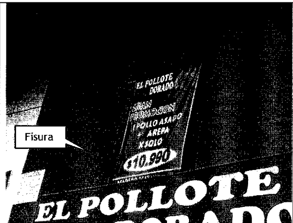
Foto 4. Fisura en muro de fachada (costado oriental sobre la Carrera 10).
