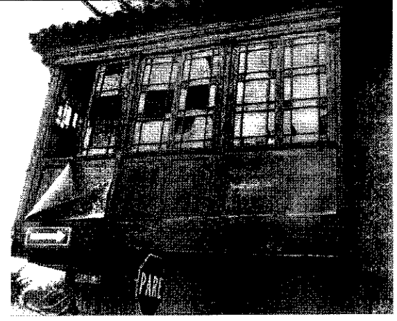
Foto 8. Vista general de estructura de madera ("balcón") ubicada en la fachada sur del inmueble; se observan desprendimientos de los elementos de madera.
