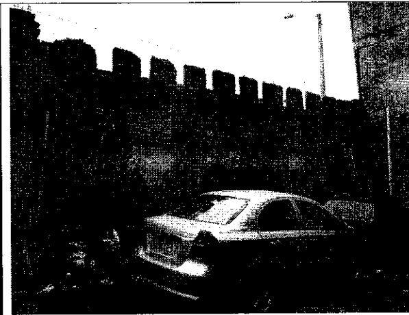
Foto 4. Vista de la cara interior del muro perimetral de fachada del costado oriental del predio.
