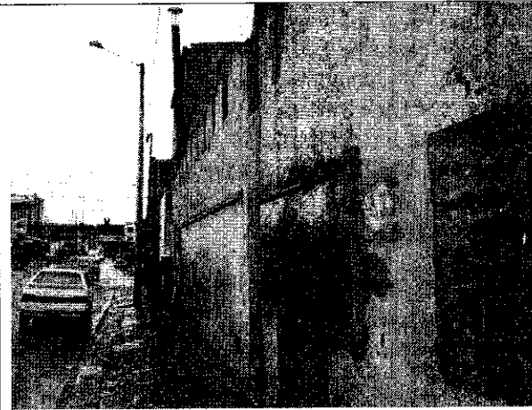
Foto 2. Aspecto general de la fachada del costado oriental, donde se observa una leve pérdida de verticalidad. Vista desde la Carrera 21.
