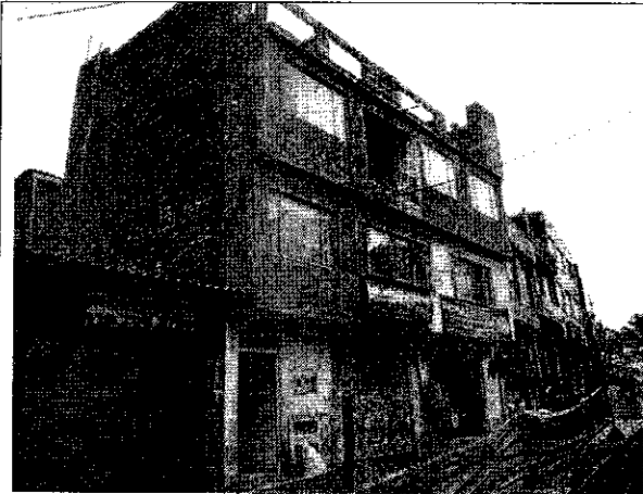
Foto 1. Aspecto general de la fachada (costado oriental) de la edificación emplazada en el predio de la Carrera 4 No. 188-39.
