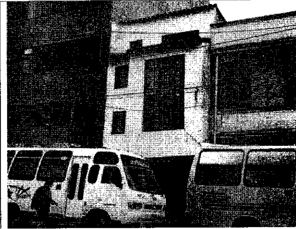
Foto 1. Aspecto general de la fachada de la edificación emplazada en el predio de la Carrera 15 No. 70 A-85.
