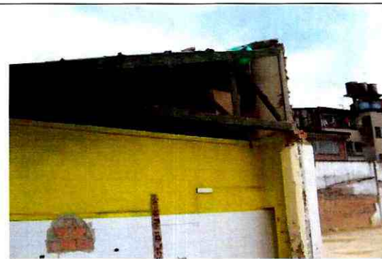
Foto 8. Cubierta del costado norte (agosto 29 de 2011).
