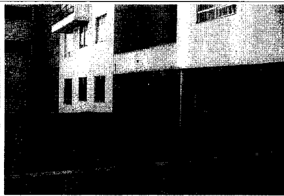
Foto 7. Estructura aporticada en buen estado.
