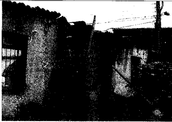
Foto 5. Sector central del muro del costado occidental en mal estado, pérdida de verticalidad considerable.
