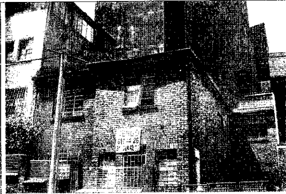
Foto 1. Vista general de la fachada del inmueble.
