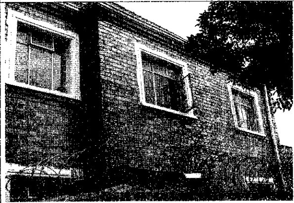
Foto 3. Aspecto de la fachada del costado oriental.
