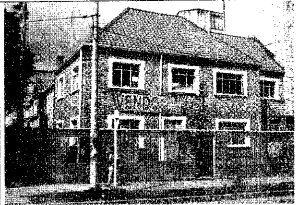
Foto 1. Vista general del inmueble.
