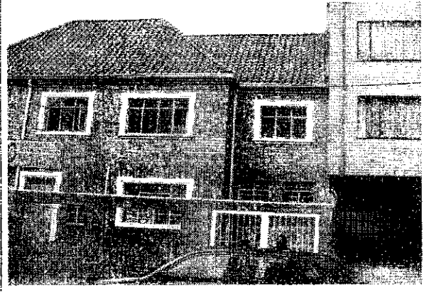
Foto 2. Fachada del costado norte en buen estado.
