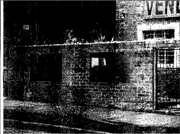
Foto 8. Muro de cerramiento en mampostería.
