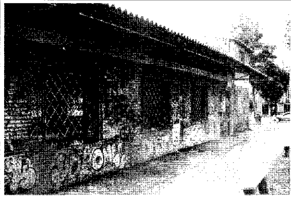
Foto 2. Fachada del costado oriental.
