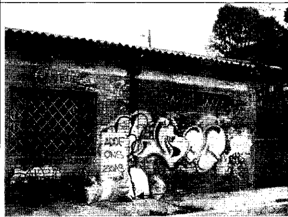
Foto 10. Asentamiento diferencial de la edificación.
