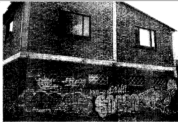
Foto 3. Fachada del costado norte.
