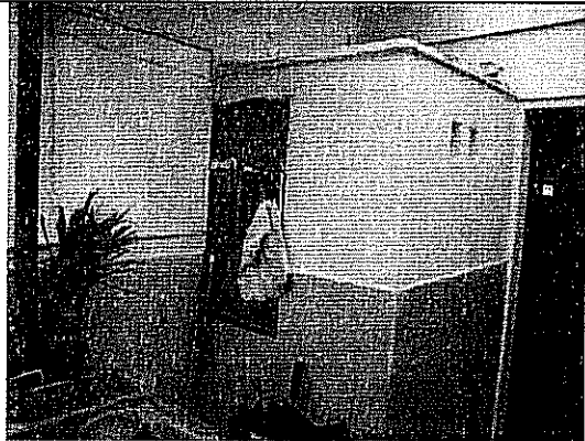
Foto 4. Muros internos del primer piso en buen estado
