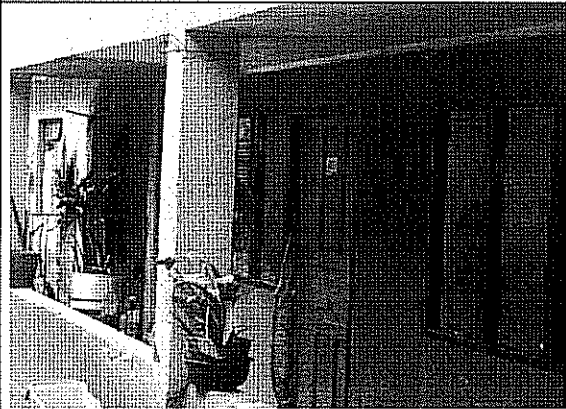
Foto 5. Columnas de la zona frontal en buenas condiciones.
