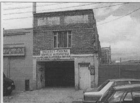
Foto 1. Fachada de la edificación en las condiciones presentes al momento de la visita.
