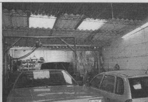
Foto 4. Vista interna de primer piso, sin daños estructurales apreciables.
