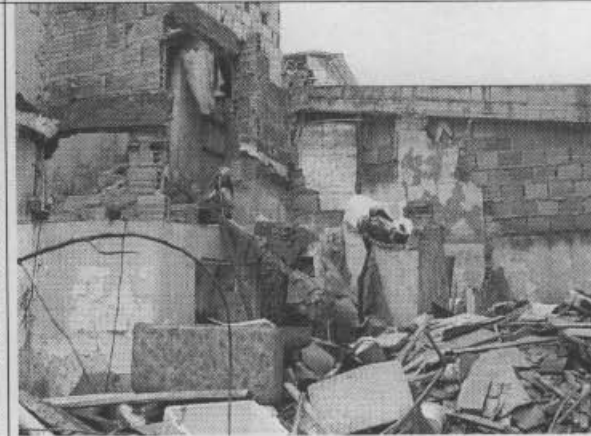
Foto 4. Demoliciones y escombros.
