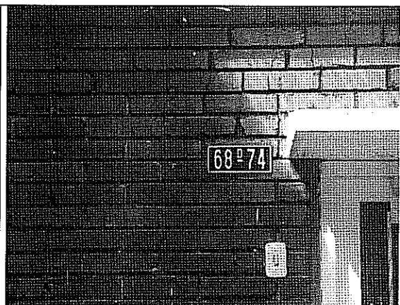
Foto 2. Muro de fachada en buenas condiciones.
