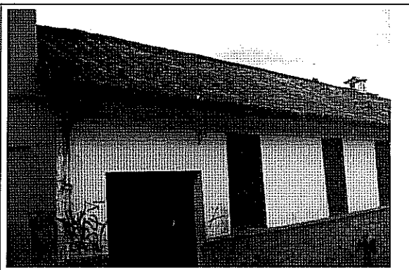
Foto 2. Muro de fachada y cubierta de la zona frontal en buen estado.
