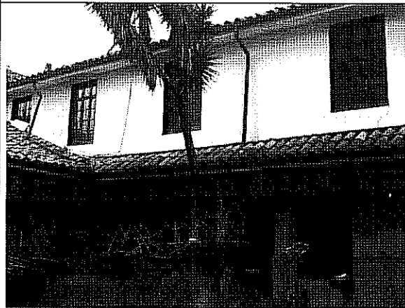
Foto 3. Muros internos de fachada en buenas condiciones.
