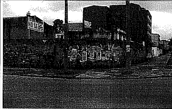
Foto 1. Aspecto general del muro de cerramiento.
