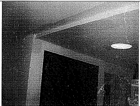
Foto 4. Divisiones y cielo raso en láminas de yeso.
