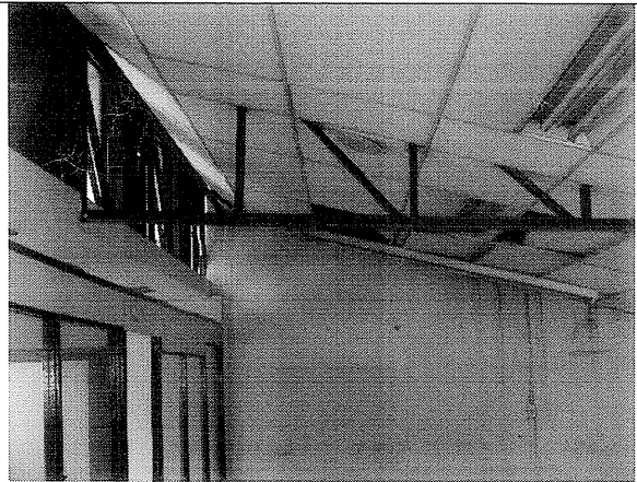
Foto 6. Cubierta del costado oriental en buen estado.
