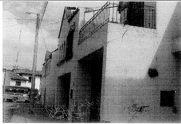
Foto 3. Muros de fachada en buen estado.
