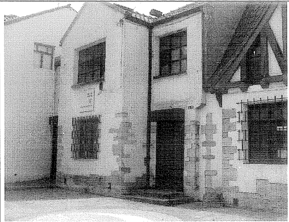
Foto 2. Fachada del costado norte.
