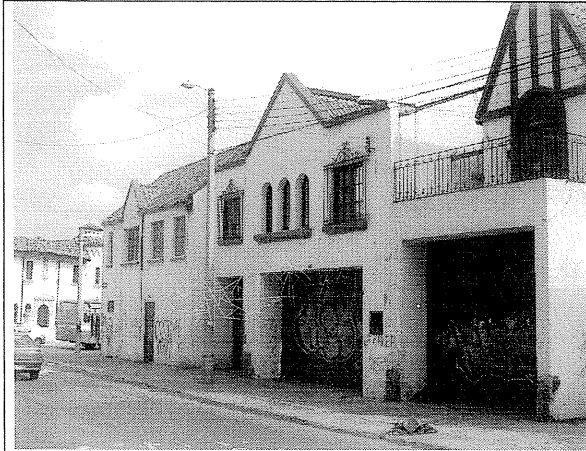
Foto 1. Vista general de la fachada del costado sur.
