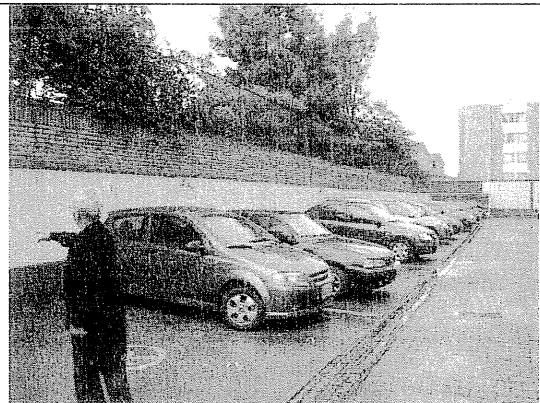
Foto 8. Vista general del muro medianero del predio de la Calle 89 No. 85 A - 35.
