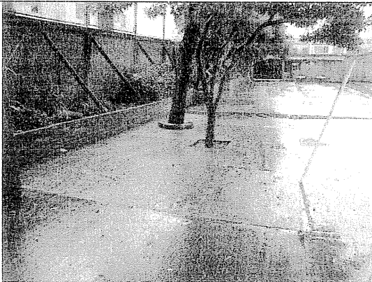
Foto 7. Disposición general de los elementos de madera.
