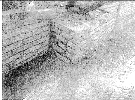
Foto 4. Estado actual de la jardinera adosada al muro del Colegio Simón Bolívar.
