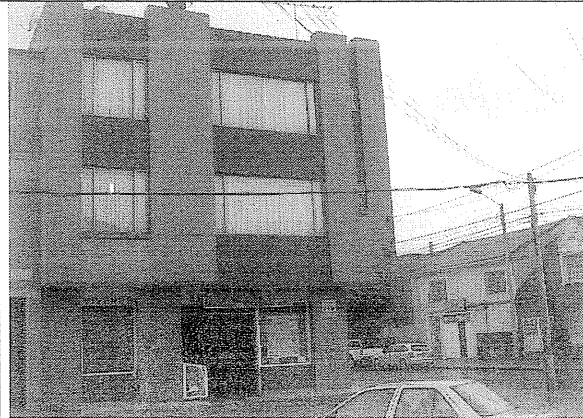
Foto 1. Aspecto general muro de fachada costado norte.
