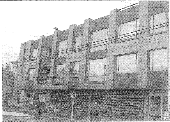
Foto 2. Muro de fachada costado occidental.
