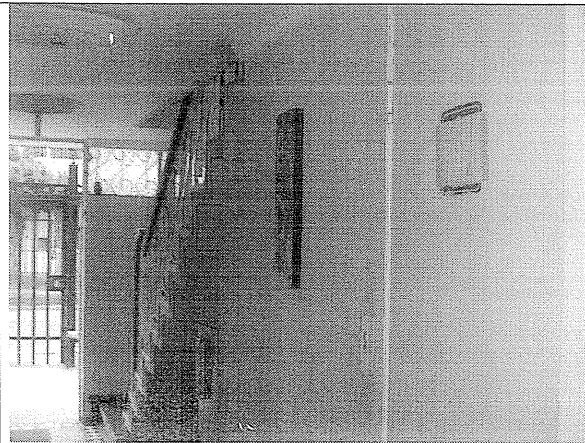
Foto 3. Muros internos en buen estado.
