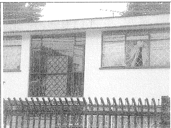
Foto 2. Muro de fachada en buen estado.
