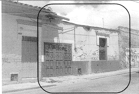
Foto 1. Aspecto general del muro de cerramiento del predio.
