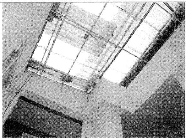
Foto 14. Cubierta liviana sin daño visible.
