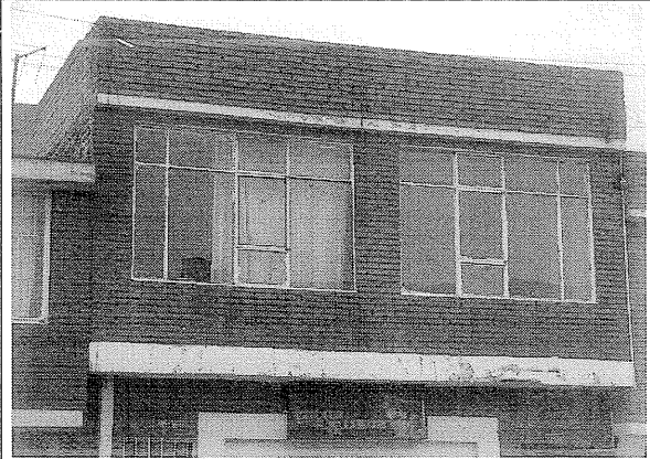
Foto 2. Muro de fachada en buen estado.
