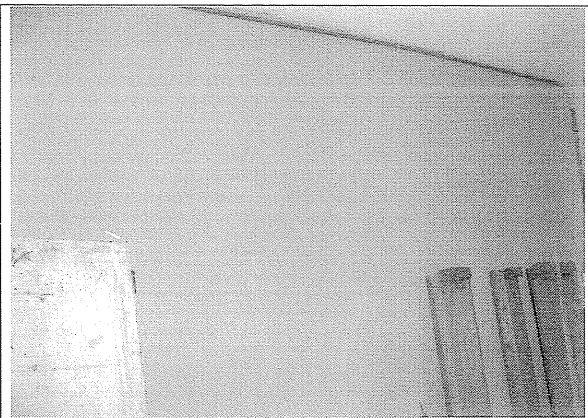
Foto 4. Muros internos de la zona frontal.
