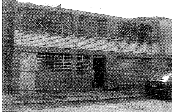
Foto 1. Aspecto general de la fachada de la edificación.
