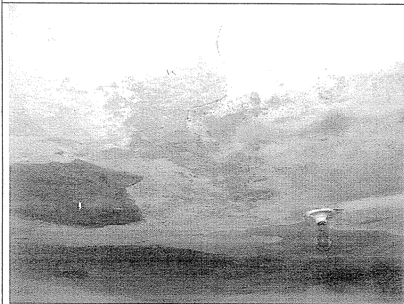
Foto 9. Placa de cubierta en malas condiciones.
