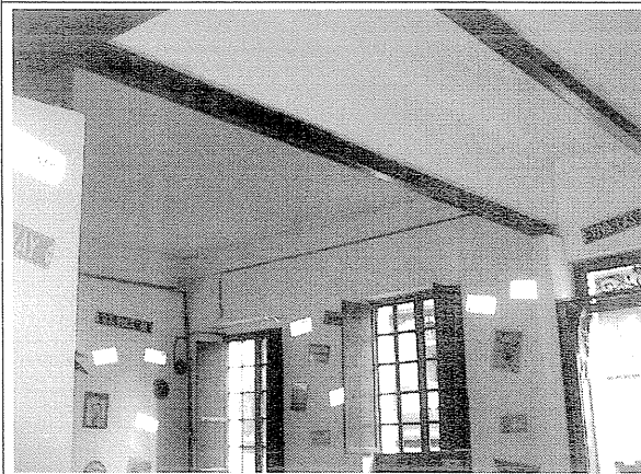
Foto 7. Elementos metálicos de refuerzo del entrepiso.
