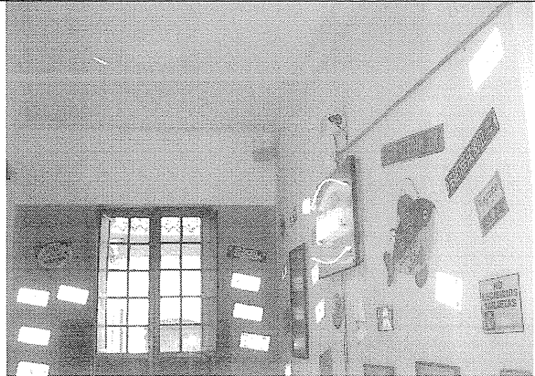
Foto 4. Muros internos del primer piso en buen estado.
