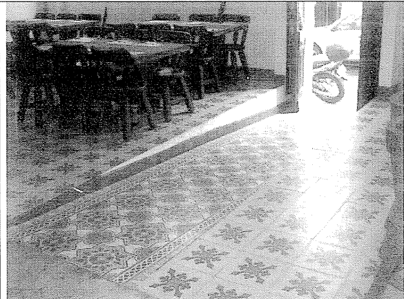
Foto 8. Acabados de piso en buen estado.
