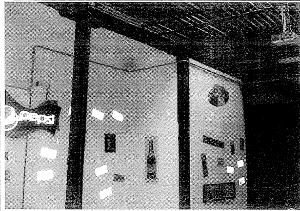
Foto 3. Aspecto de los muros internos.
