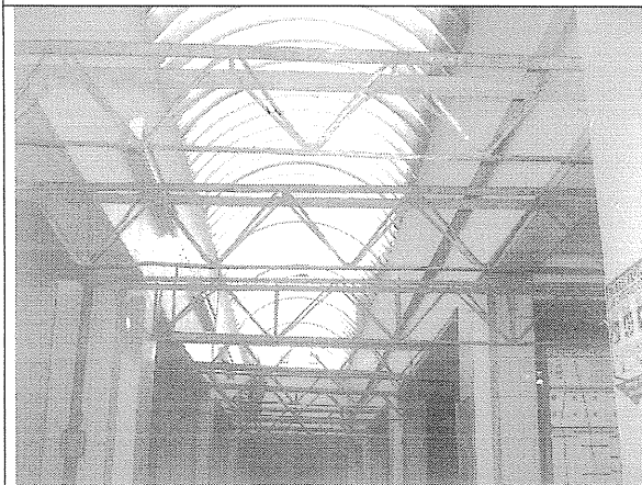
Foto 9. Apuntalamiento provisional de las vigas de cubierta.
