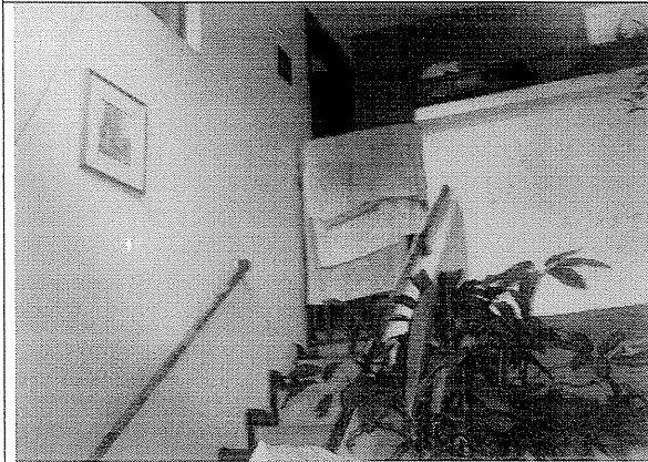
Foto 3. Muros del costado sur en buen estado.
