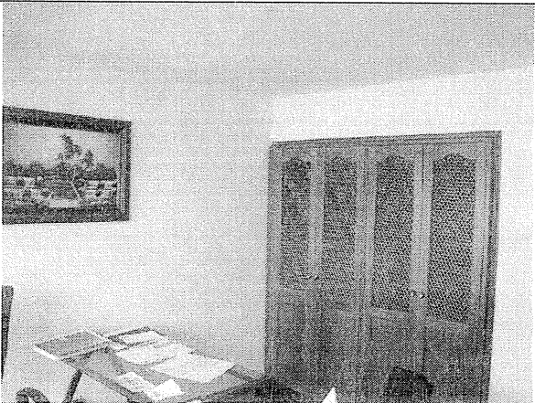
Foto 13. Muros y placa sin indicios de daño estructural.
