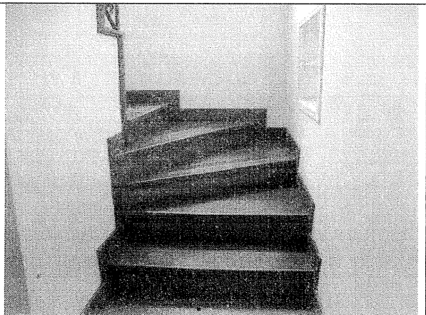
Foto 14. Escaleras sin daño estructural visible.
