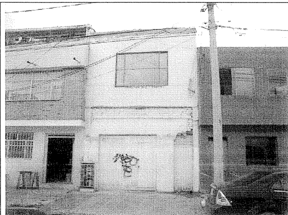
Foto 1. Aspecto general de la fachada del inmueble.
