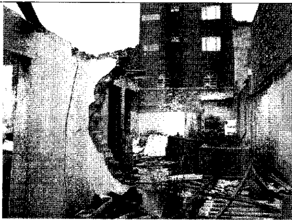
Foto 5. Fragmentos de muro sin remover.
