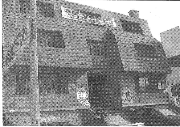
Foto 1. Aspecto general de la fachada de la edificación.
