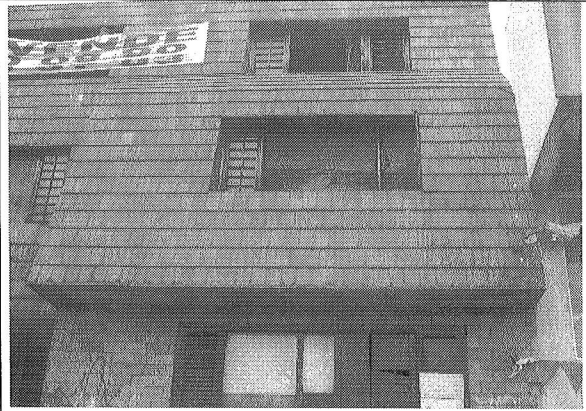
Foto 2. Elementos de fachada en buenas condiciones.
