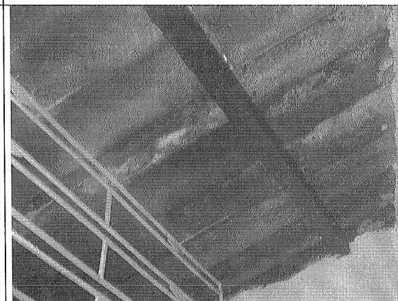
Foto 8. Cubierta en buenas condiciones.
