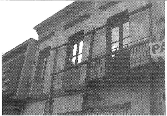
Foto 2. Apuntalamiento provisional del muro de fachada.
