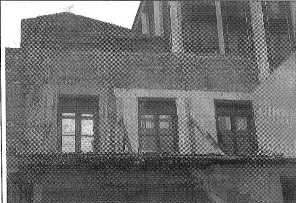
Foto 3. Apuntalamiento provisional en la cara interna del muro de fachada.
