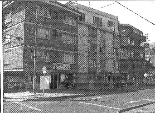
Foto 1. Aspecto general de la edificación.
