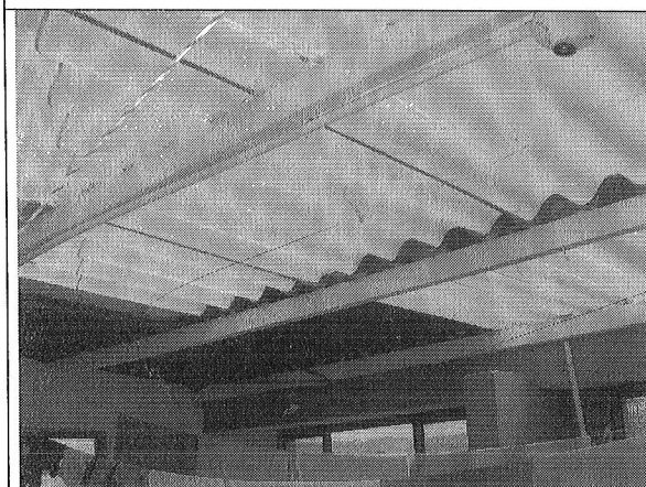
Foto 5. Placas de entepiso en buen estado.
