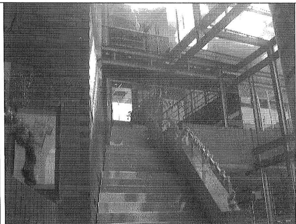
Foto 10. Escaleras en buenas condiciones.
