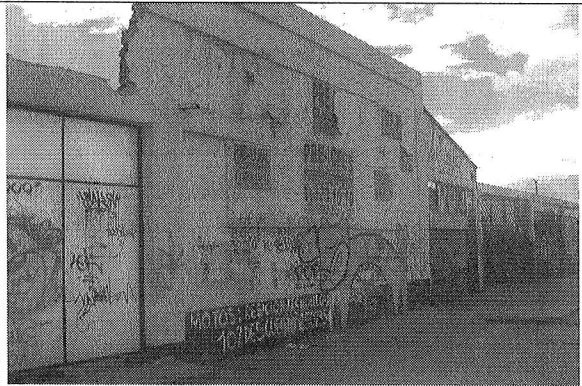
Foto 2. Vista del muro de cerramiento del costado norte.
