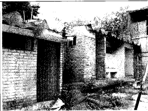
Foto 19. Edificación del sector posterior en buen estado.
