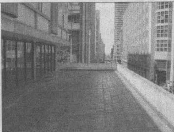
Foto 3. Cubierta del local.
