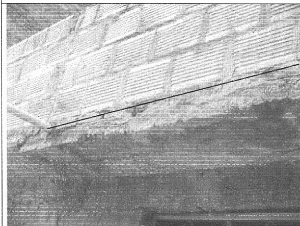
Foto 9. Deflexión en el extremo oriental de la placa de la parte posterior.
