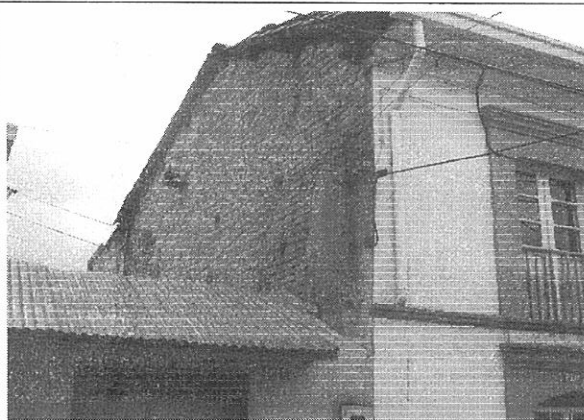
Foto 3. Muro culata del costado oriental en buenas condiciones.
