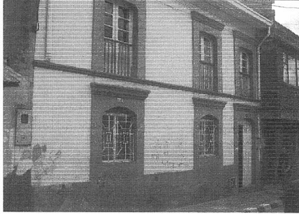
Foto 1. Vista general de la fachada del inmueble.
