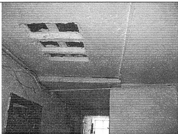
Foto 19. Placa de entrepiso en buenas condiciones.
