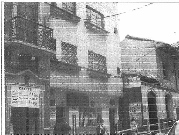
Foto 1. Vista general del inmueble
