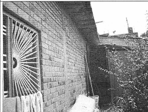
Foto 5. Muros posteriores sin daños, no existen afectaciones considerables.
