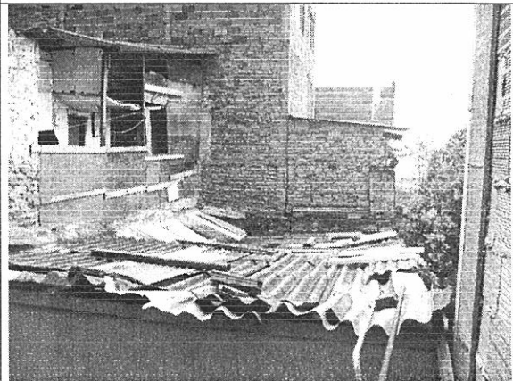
Foto 12. Aspecto de la cubierta del sector posterior.
