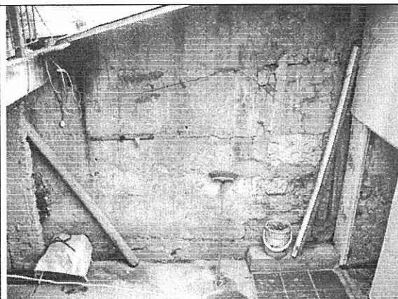
Foto 7. Tramo central del muro de lindero sur.
