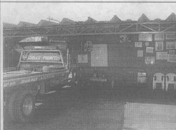
Foto 3. Estado interior del inmueble, aparentemente sin daños estructurales.
