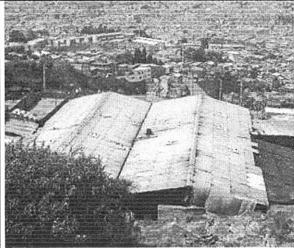
Foto 8. Cubierta en buenas condiciones
